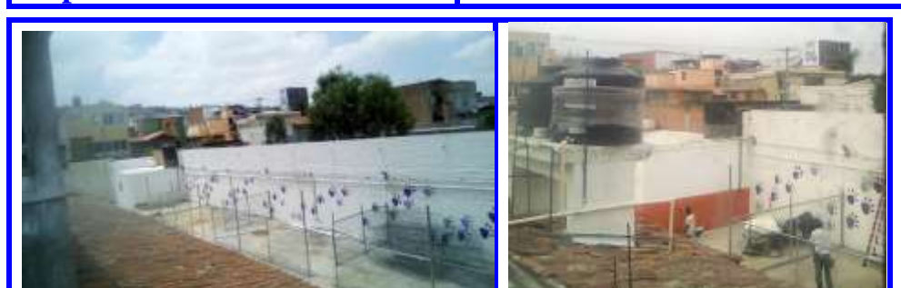
Pozo de Agua para cuya perforación se requiere permiso de CONAGUA
